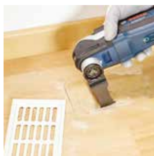
Врезное пиление в ламинате, например, при монтаже вентиляционной решетки
