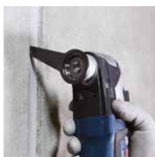
Расшивка деформационных швов
