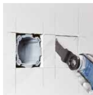
Легкое выполнение погружных пропилов в гипсокартонных плитах
