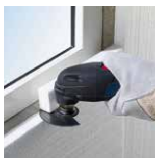
Подрезание выступающего изоляционного материала (например, стиропора) заподлицо с поверхностью
