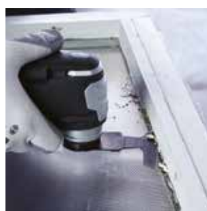
Расшивка швов оконного герметика (замазки)
