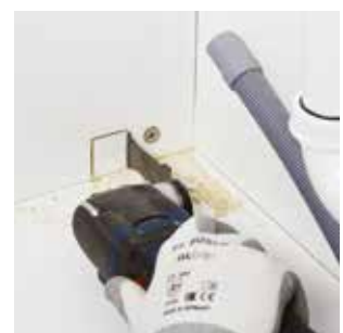
Высокоточные погружныерезы в плитах с покрытием, например, при изготовлении выреза для кабельного канала
